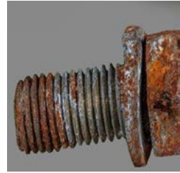
Corrosão em roscas
